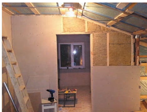
Идет монтаж электропроводки
