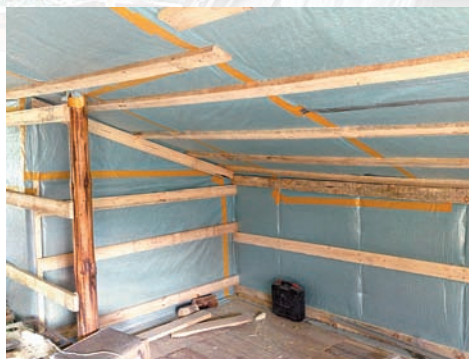
Чердак перед обшивкой гипсокартоном
